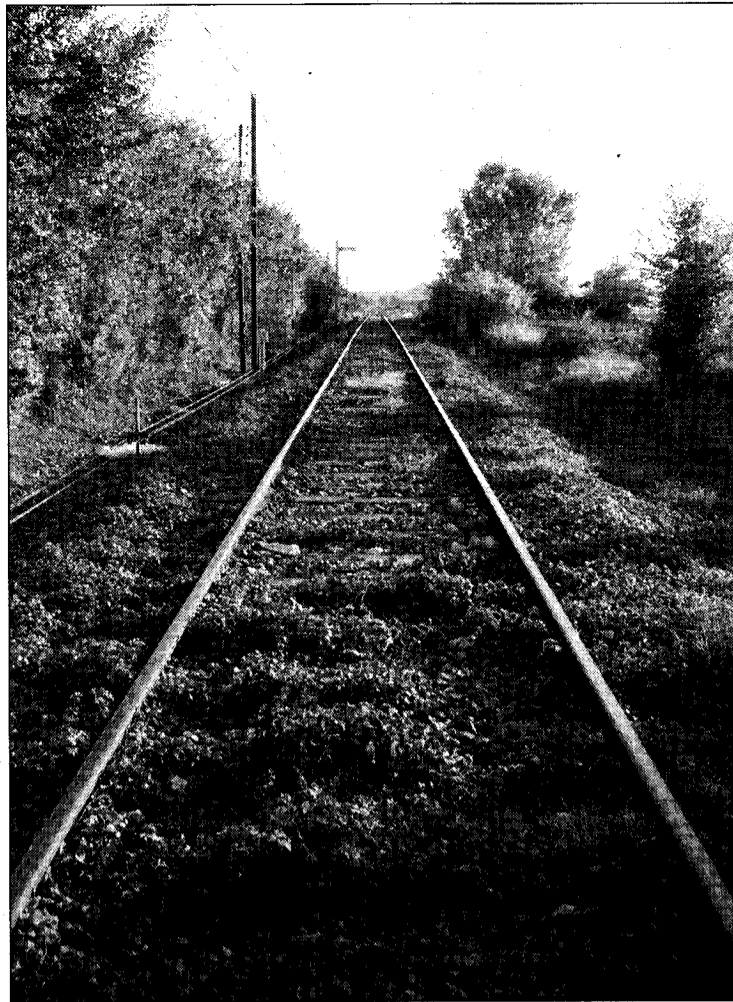
Imagen del tramo actual Huesca-Caldearenas.D.A.
