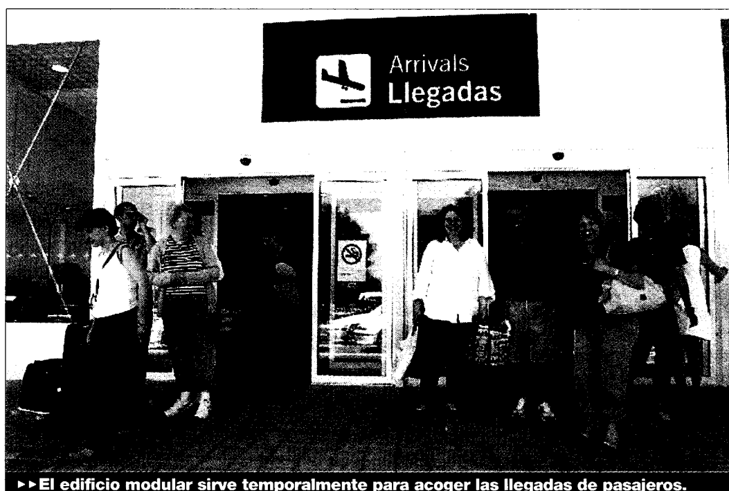
► El edificio modular sirve temporalmente para acoger las llegadas de pasajeros.
