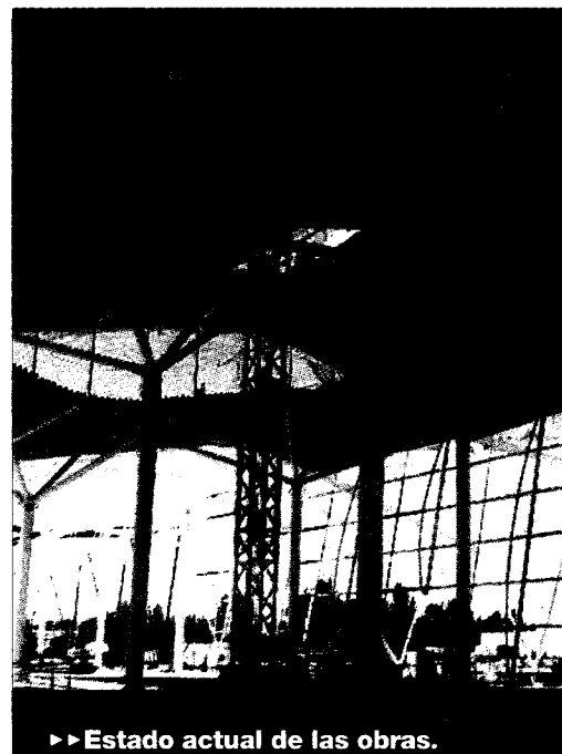
►► Estado actual de las obras.
