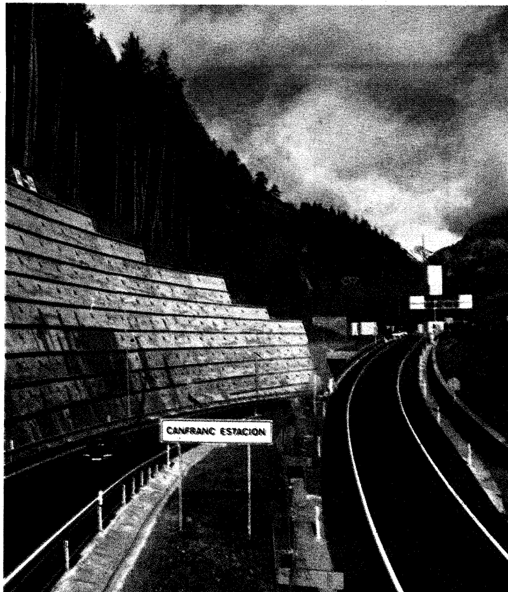
El túnel necesitó casi diez años de obras, lo cofinanció la UE y se inauguró en enero de 2003
