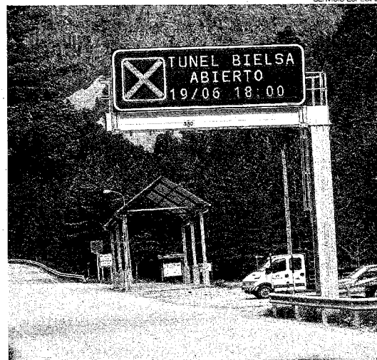
►► El túnel de Bielsa, ayer ya abierto.
